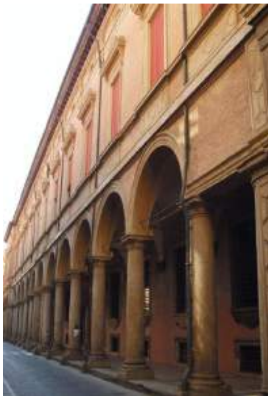
Figura 8 - Il Portico di Palazzo Poggi in via Zamboni
