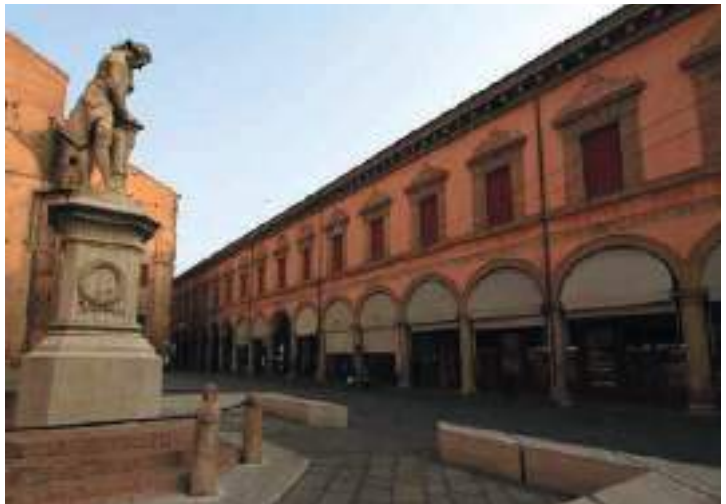
Figura 3 - Il Portico del Pavaglione nel tratto prospiciente Piazza Galvani
